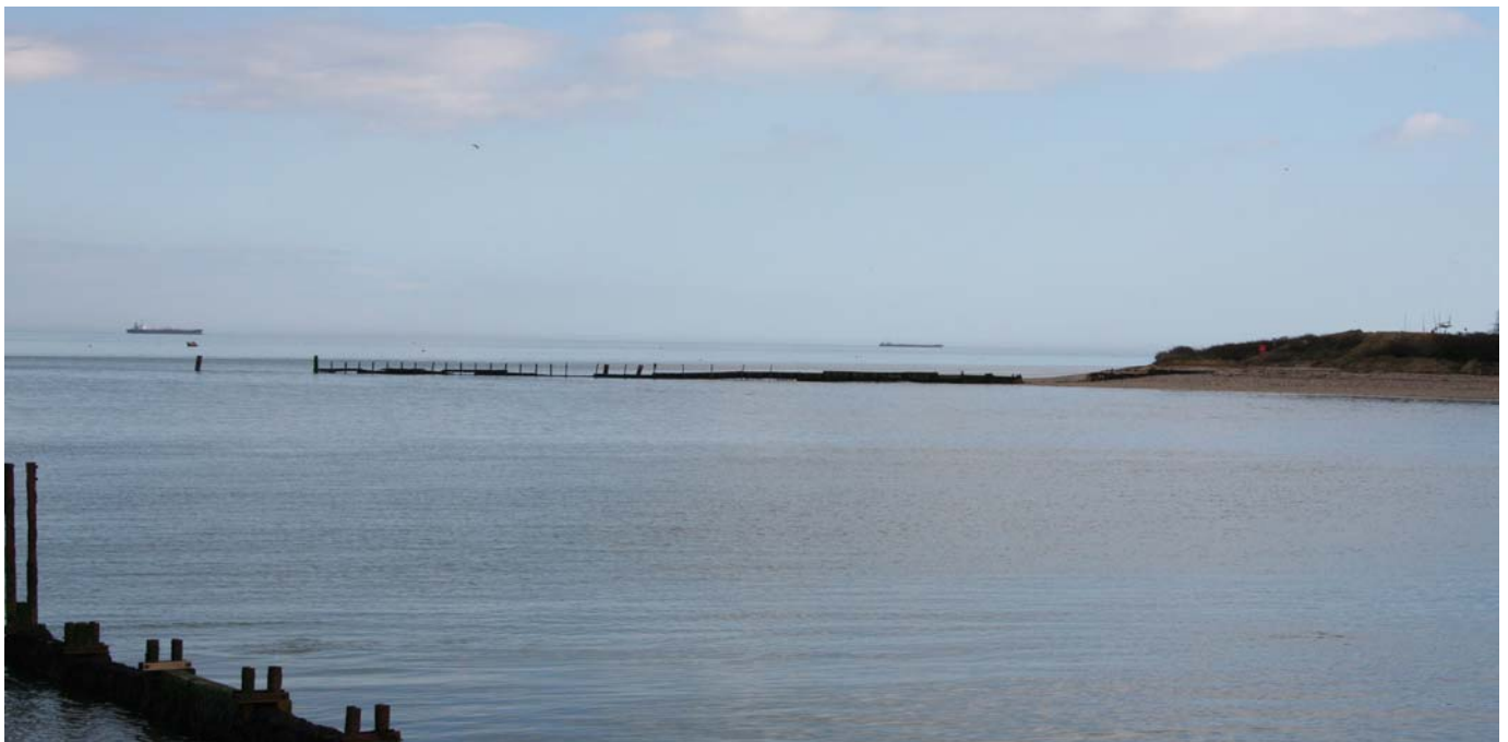
Bembridge point groyne
